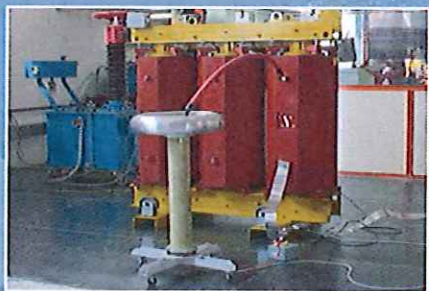
Misura di Scariche Parziali
