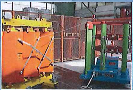
Prova a Impulso Atmosferico (Prova di Tipo)
