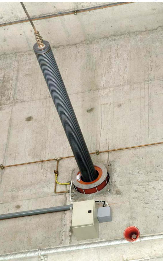
Wanddurchführung Wall bushing Traversée murale 145 kV - 400 A
